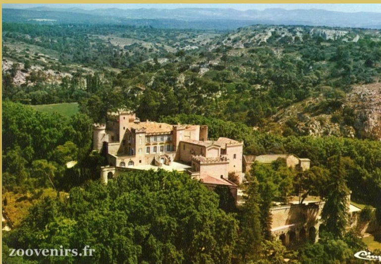
Vue aérienne du château
