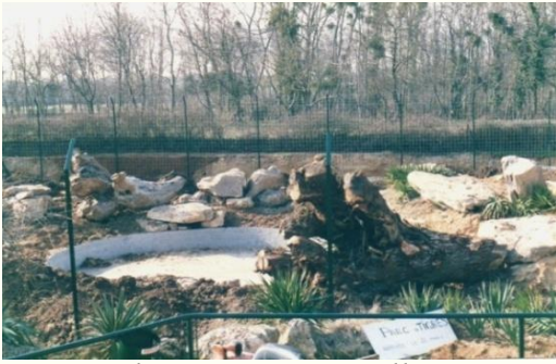
Le parc des tigres « nouvelle version » en travaux.
