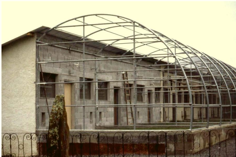
Nouvelles installations en construction pour les différentes espèces de lémuriens
